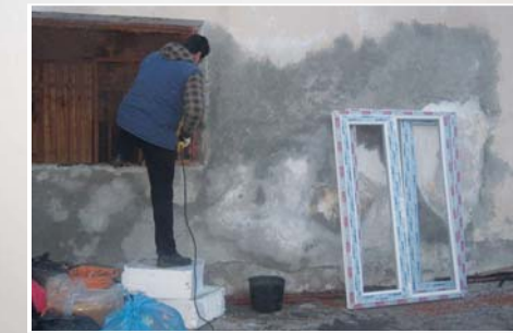
... für die neuen Fenster, die jetzt Wind und Kälte abhalten.
